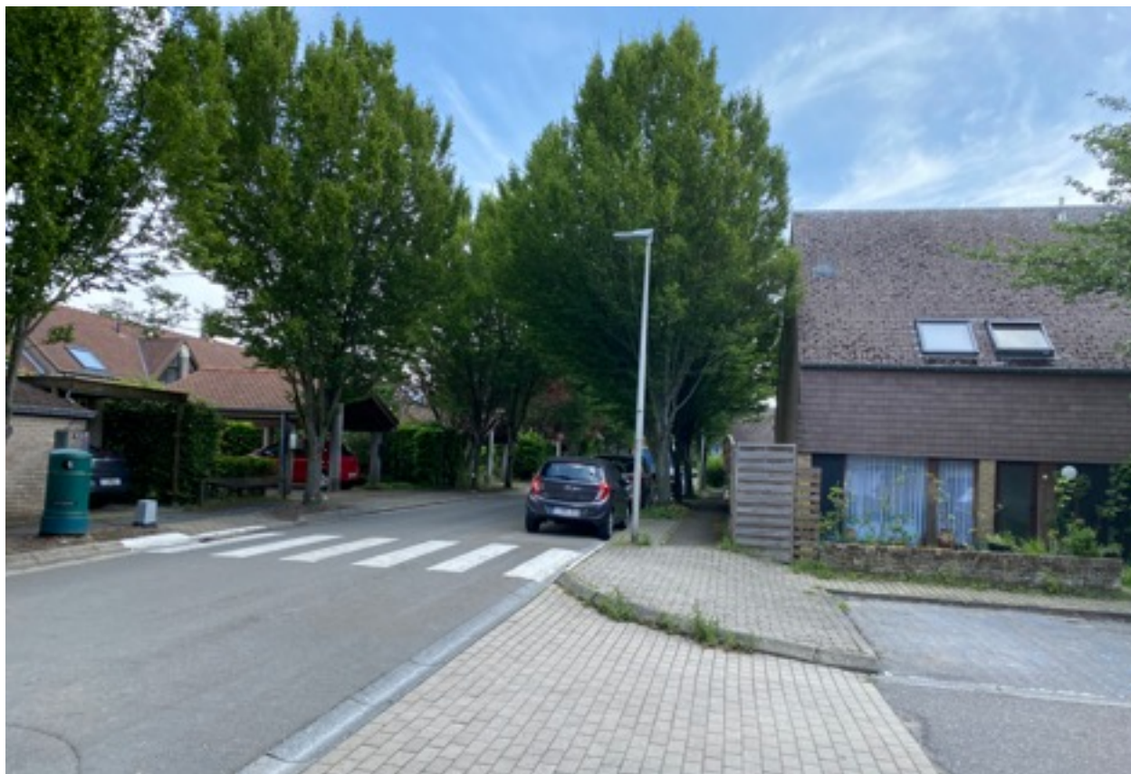
Les rénovations concernent les maisons des rues Marie d'Oignies et de Villers à Louvain-la-Neuve.
